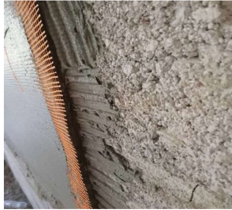
Wärmedämmung von Gebäuden
